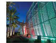
maani METALFORM CONSTRUCTION
