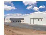
maani STEEL CONSTRUCTION
