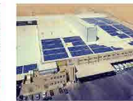
maani SOLAR CONSTRUCTION
